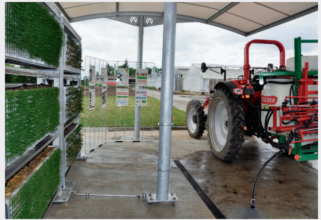
Fig. 4 Aire de lavage équipée d'un VG-biobed™ Mit VG-Biobed™ ausgerüstete Waschfläche
